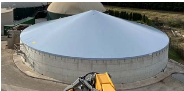
Figura 6. Dipòsit de purins amb cobertura conoide. Font: UPBIOGAS.
