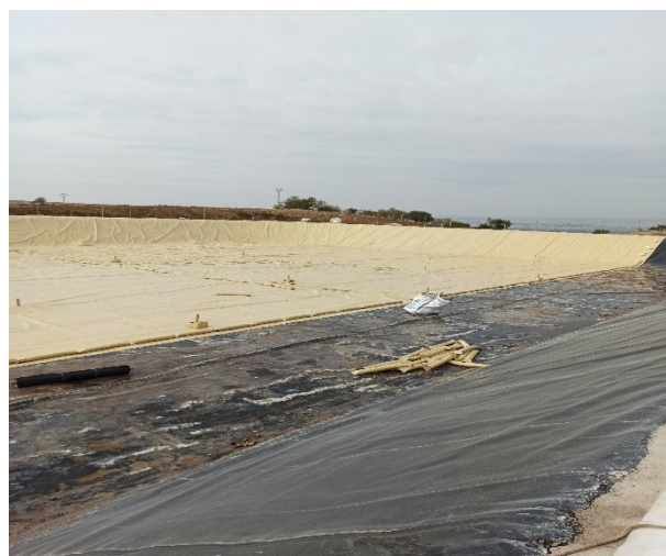
Figura 8. Vista general i d'instal·lació de làmina flotant a bassa. Font:DACC
