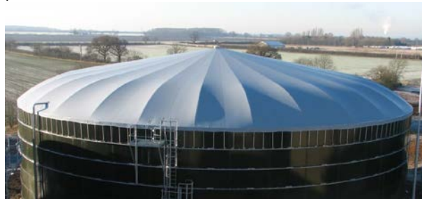
Figura 7. Coberta amb estructura interna de suport. Font: Dendromon.
