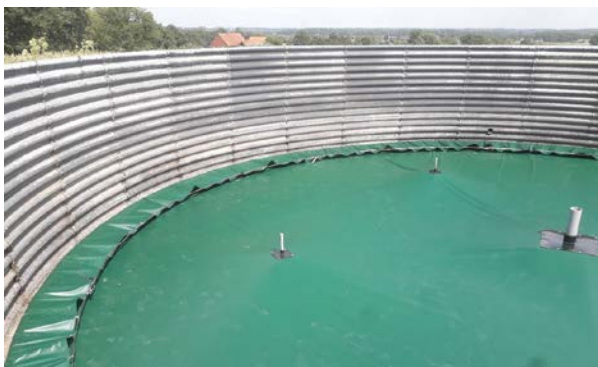
Figura 4. Coberta flotant per a dipòsits circulars. Font: Dendromon.
