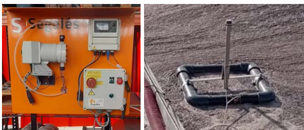
Figura 6. Panell equip dosificació i sistema flotant de mesura de pH a la bassa. Font: Mecàniques Segalés SL.
