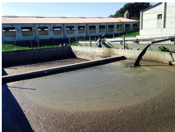
Figura 1. Bassa de recepció de purí porcí. Font: DARP
