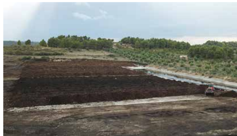
Vista aèria de les piles de compostatge
