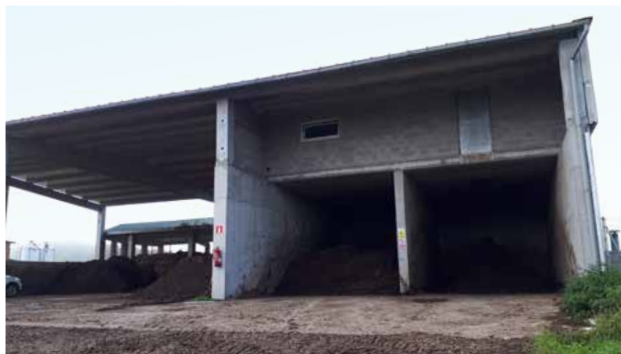
Fotografia 21. Imatge de l'experiència c). A la dreta, mòduls per a descomposició (compostatge estàtic, treballant en aspiració) i maduració (a l'esquerra).
