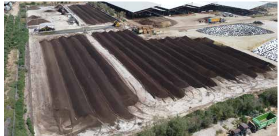
Fotografia 19. Imatge aèria de la planta de compostatge (l'experiència a)
