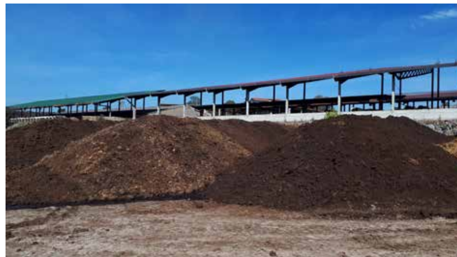
Fotografia 22. Imatge de piles de compostatge en descomposició de l'explotació de l'experiència d)
