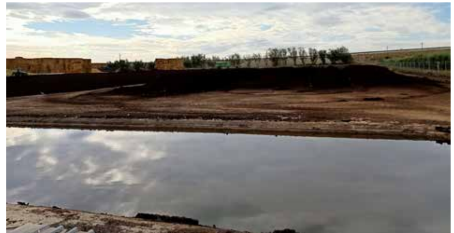
Fotografia 18. Bassa de recollida de lixiviats d'una planta de compostatge
