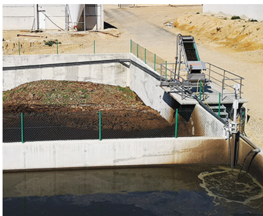
Figura 6. Sistema de tractament de separació sòlid-líquid
