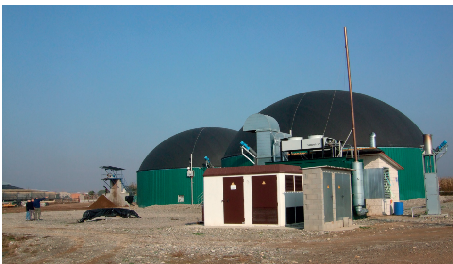
Figura 3.4.2. Imatge superior: Digestor anaerobi en una granja relativament petita, consistent en una bassa de purins coberta per a la recuperació del biogàs generat. Imatge inferior: Planta de digestió anaeròbia consistent en dos reactors CSTR per al tractament de purins en una gran explotació.
