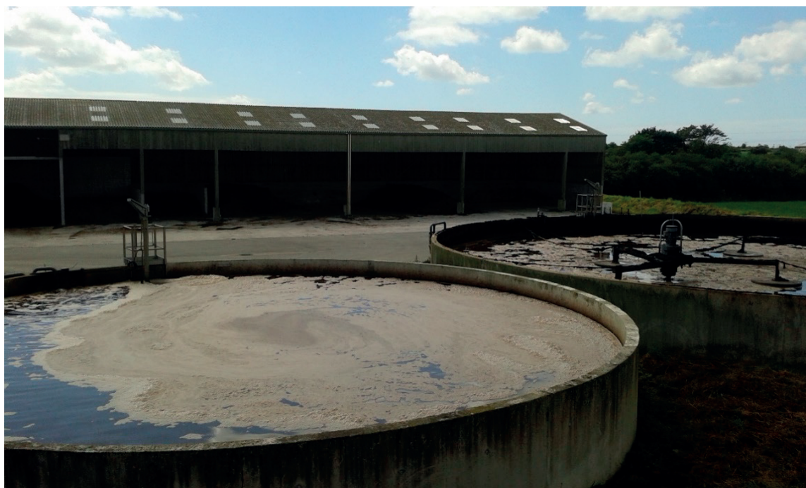
Figura 3.5.2. Imatge superior: Planta de nitrificació-desnitrificació mitjançant aeració intermitent en un únic reactor (SBR), que consta d'un dipòsit de recepció dels purins (A), un separador sòlid-líquid de cargol-prensa (B), una zona d'emmagatzematge de la fracció sòlida (C) i de la fracció líquida (D), un reactor de nitrificació-desnitrificació (E), i la bassa d'emmagatzematge de l'aigua tractada (F). Imatge inferior: Reactors òxic i anòxic separats pel tractament en continu de la fracció líquida dels purins.
